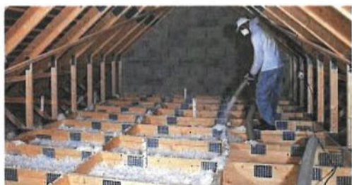
Isolation combles perdus
